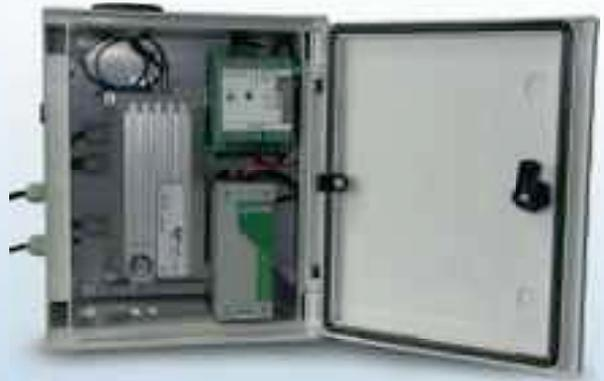
Estación de aforo para aguas superficiales; conexión a la red con batería, registro de valores medidos en intervalos de minutos, transmisión de datos en intervalos de 15 minutos; además, la transmisión de datos se conmuta automáticamente a 5 minutos si se superan los valores límite.
