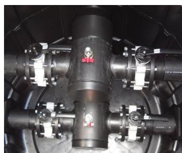
El colector principal para la conexión de 2 sub-arquetas
