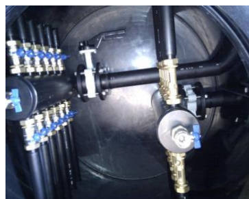
Arqueta con colectores y válvulas de cierre
